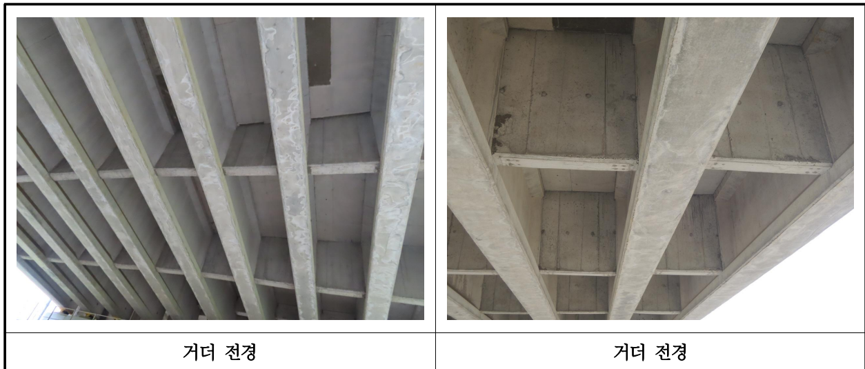
【사진 3.3.4】 거더 전경
