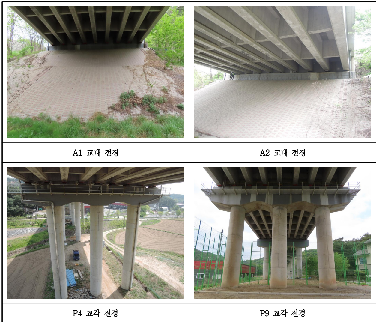
【사진 3.3.8】 교대 및 교각 전경
