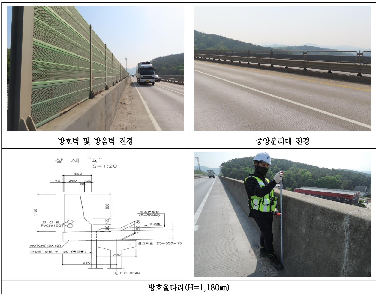
【사진 3.3.20】 난간 및 연석 전경
