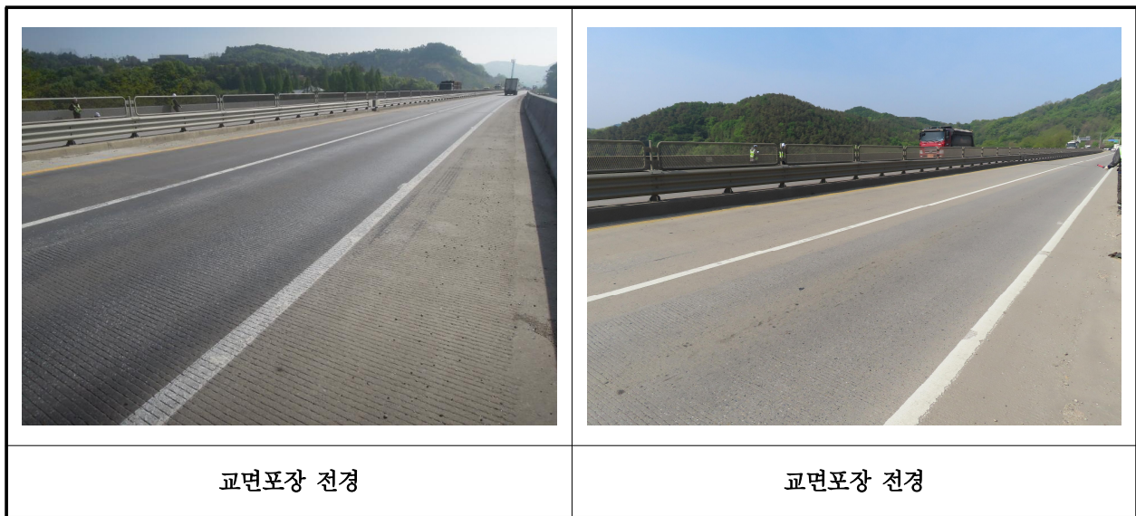
【사진 3.3.16】 교면포장 전경
