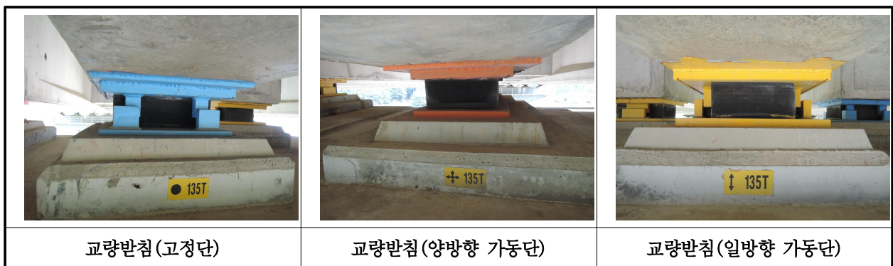
【사진 3.3.11】 교량받침 전경
